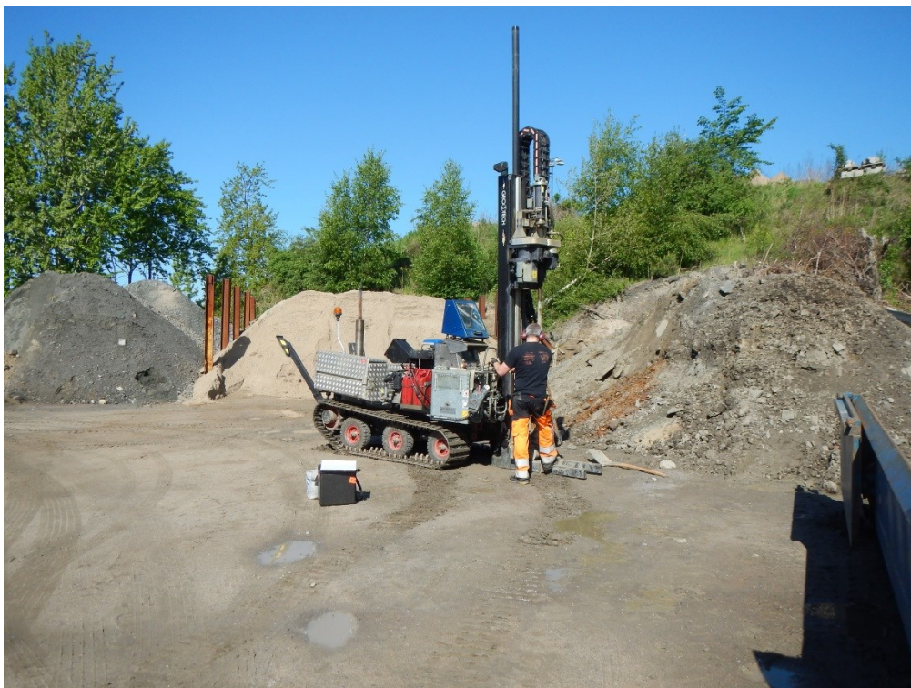
Figur 3. Skruvborrning för upptagning av jordprover i Bh8.
